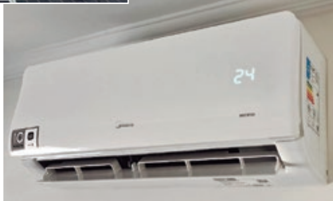
Aparelhos instalados pelo time da Climatização Saltense
