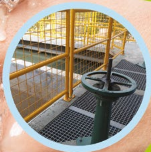
NOVOS FILTROS E REFORMA DE EQUIPAMENTOS NA ETA RANCHO GRANDE
