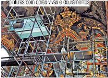
Durante as obras foram descobertas pinturas com cores vivas e douramentos
