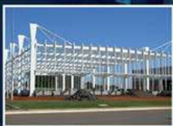
Edifícios Industriais "Parque Industrial Brasileiro - Sumaré/SP"
