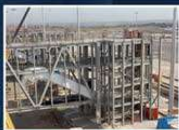
Edifícios Múltiplos Andares "Aeroporto de Viracopos"
